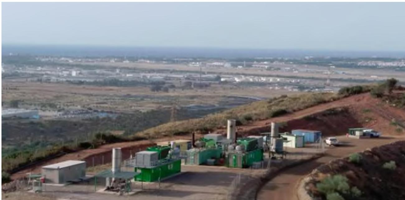
Para extraer el biogás generado como consecuencia de los procesos de degradación de la materia orgánica que tiene lugar en la masa de residuos del vertedero, el CAM cuenta con una amplia red de desgasificación integrada por un entramado de pozos de captación del biogás, una red de tuberías para el transporte del mismo y una central de extracción y regulación del biogás generado.
