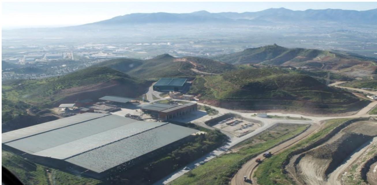
Esta planta cuenta con área que soporta el mayor tráfico de vehículos de transporte de residuos municipales que provienen de los diferentes puntos de recogida de la ciudad. Dicha zona se ha dispuesto en la plataforma más alta para permitir la adecuada descarga de los residuos en los fosos de residuos. En ella se disponen de plataformas para la maniobra de posicionamiento de camiones en las playas de descarga de residuos.
