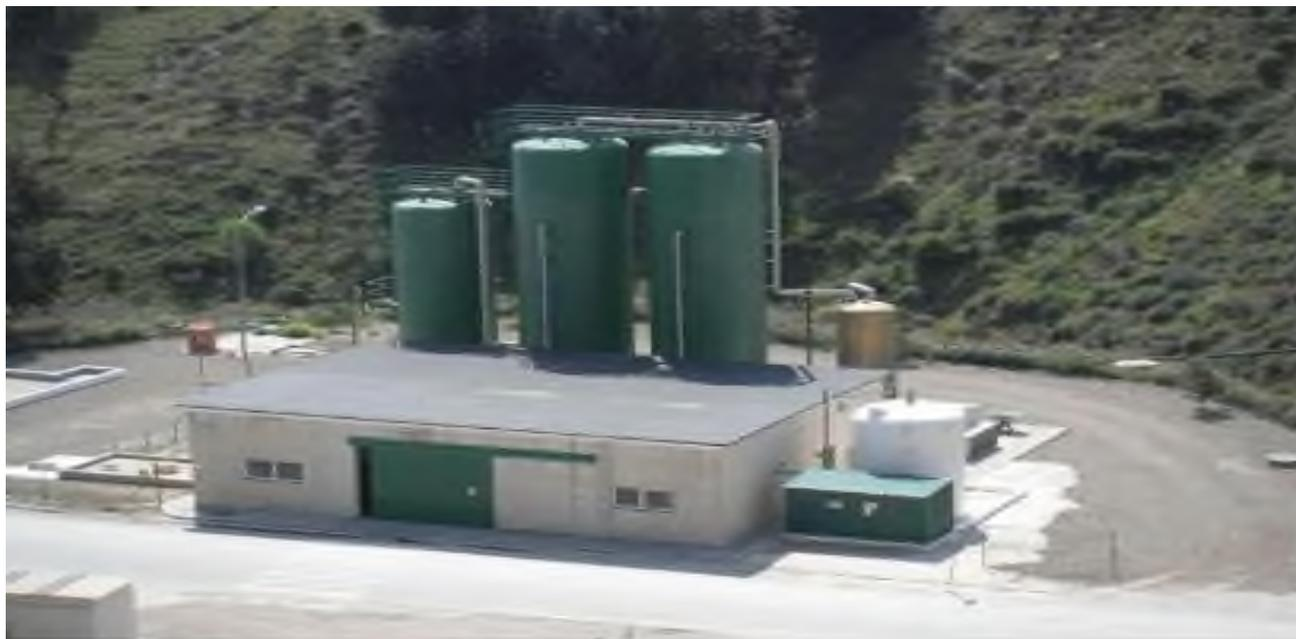
Los lixiviados producidos, tanto en el vertedero ya sellado, como en la nave de fermentación aeróbica de la Planta de Tratamiento biológico mecánico, son conducidos hasta las dos balsas dispuestas para su recogida y almacenamiento.
