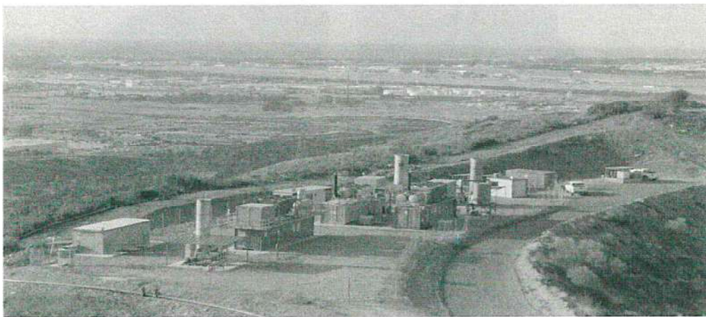
Planta de desgasificación y aprovechamiento eléctrico
