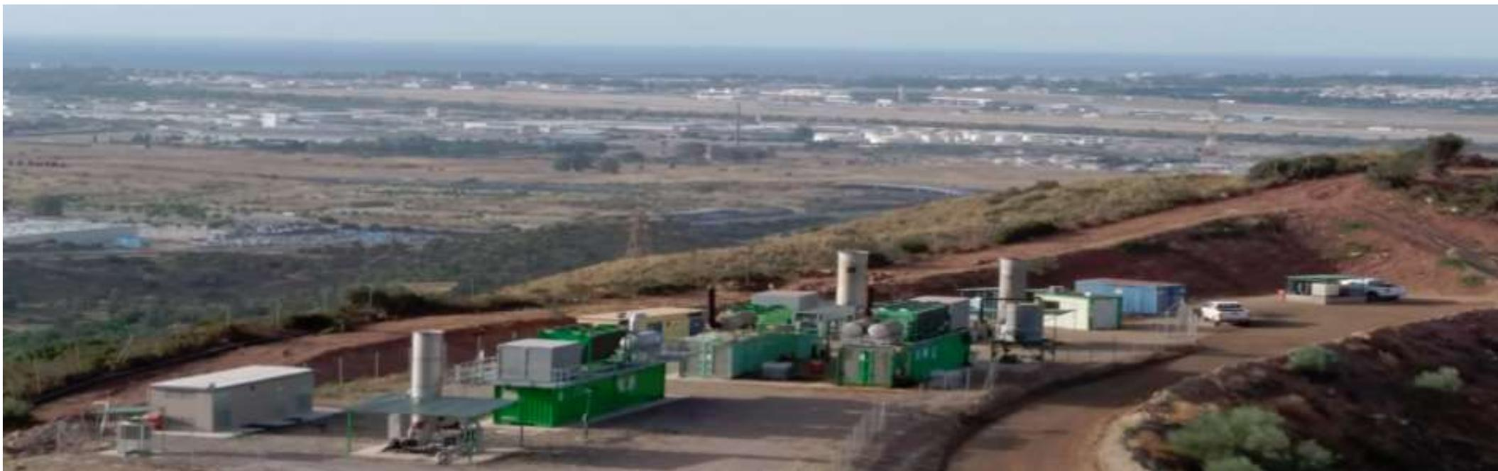
Para extraer el biogás generado como consecuencia de los procesos de degradación de la materia orgánica que tiene lugar en la masa de residuos del vertedero, el CAM cuenta con una amplia red de desgasificación integrada por un entramado de pozos de captación del biogás, una red de tuberías para el transporte del mismo y una central de extracción y regulación del biogás generado.
