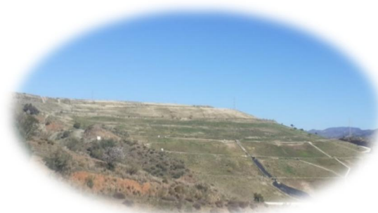
Vista revegetación del Centro Ambiental
